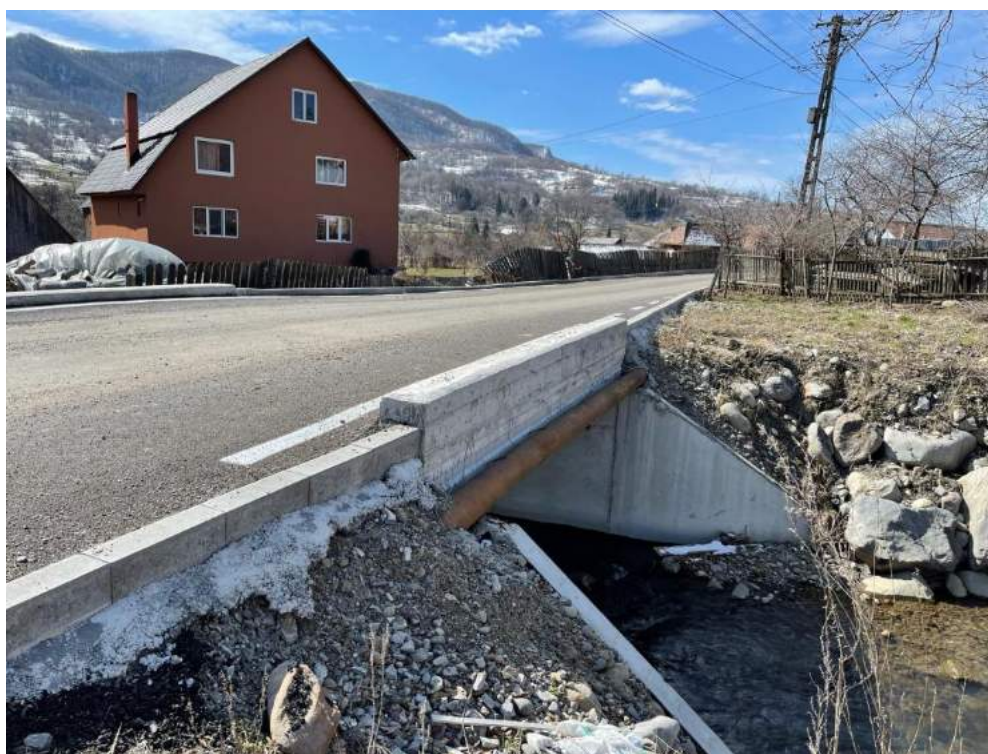
A fost terminată construcția Podului Tisieului
