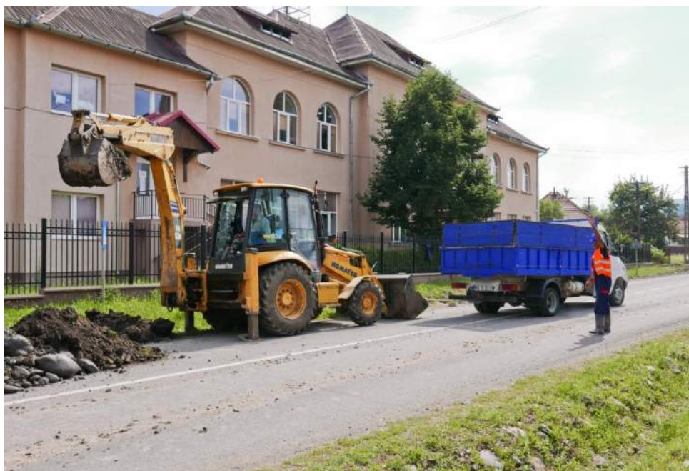
Lucrări pentru extinderea rețelei de canalizare în zona Școlii Gimnaziale Ibănești
