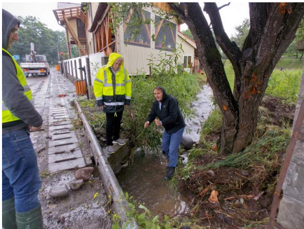
Alături de reprezentanții Consiliului Județean Mureș, la o subtraversare pe sub drumul județean din Ibănești Pădure, care a provocat pagube în timpul inundațiilor
