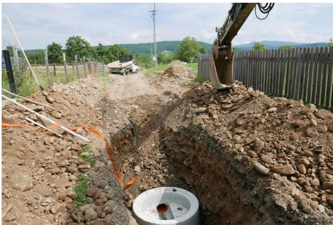
Montarea căminelor de canalizare
