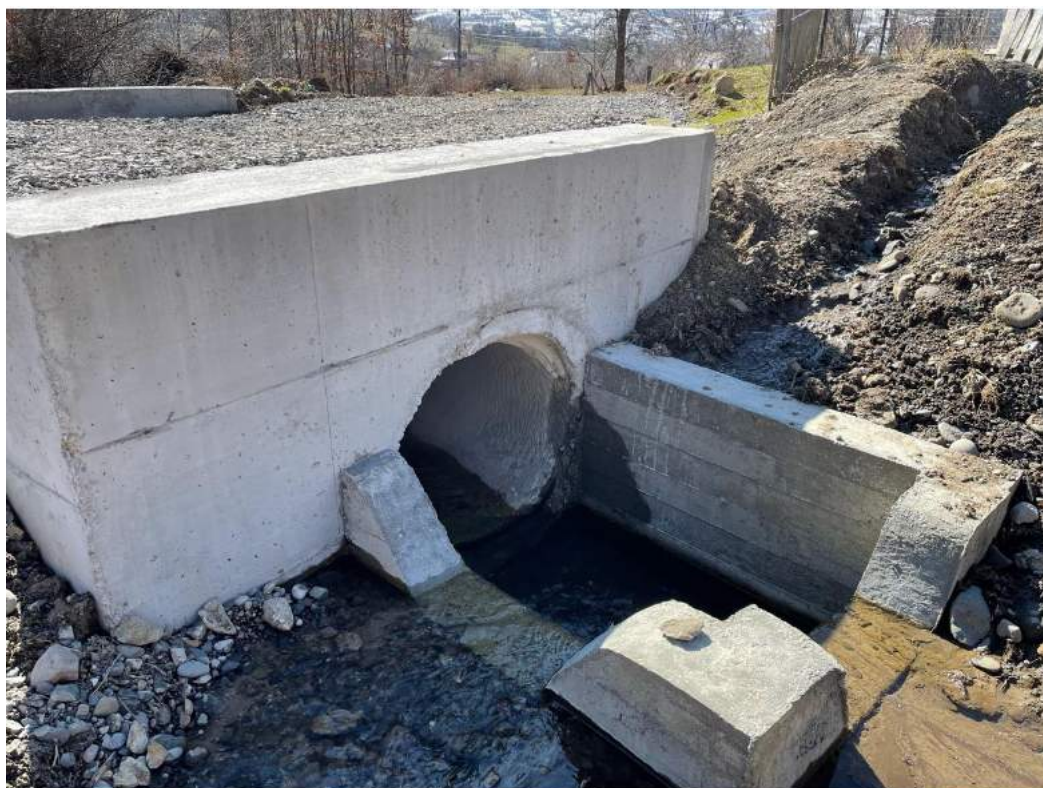
Cameră de cădere și capete de pod construite pe Tireu
