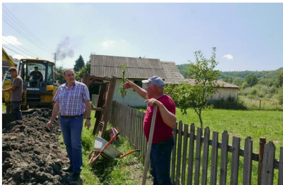
Lucrări în zona Isticeu
